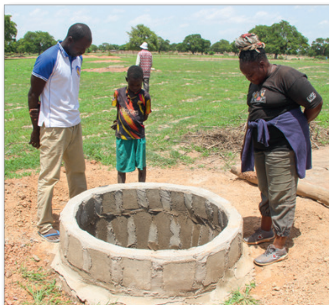
Puits maraîcher en construction à Tiogo
