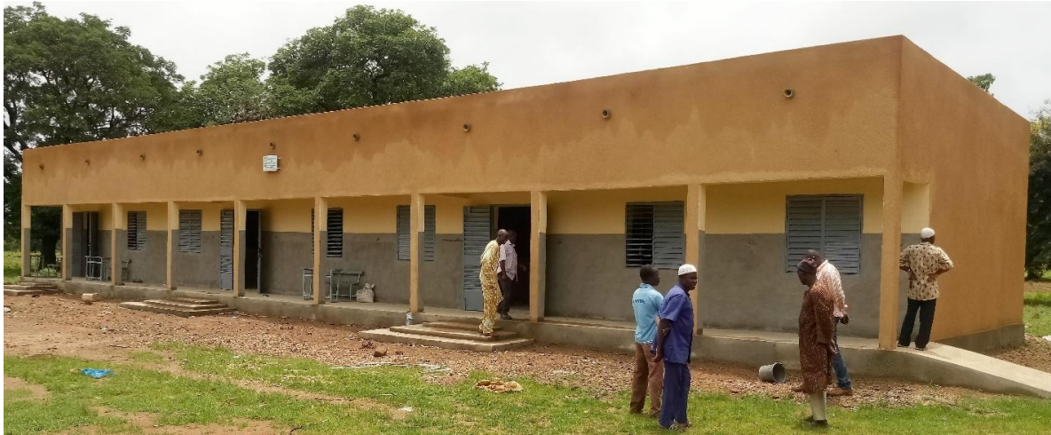
3 salles de classe construites et équipées à Djandoro en 2017 – vue extérieure
