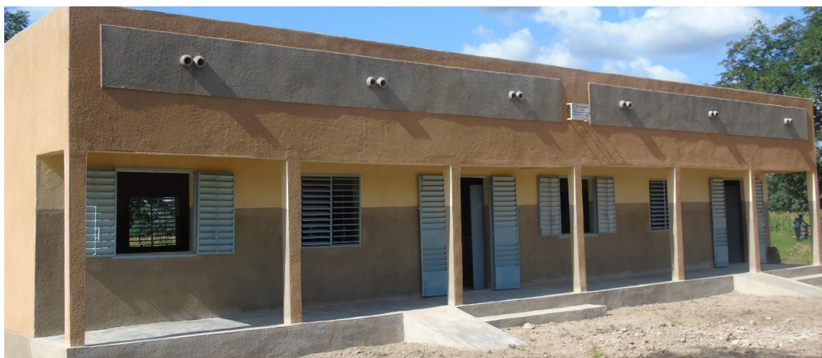
2 salles de classe construites et équipées à Gouera en 2016 –vue extérieure
