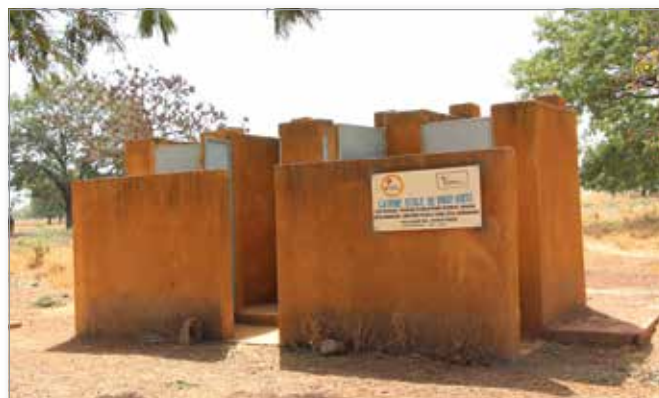
Latrines pour l'école primaire
