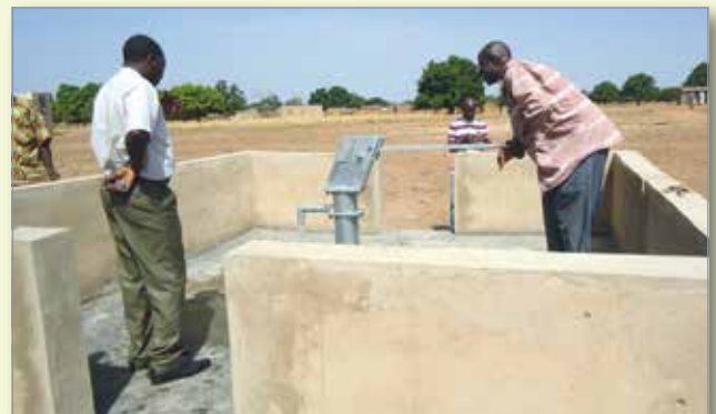
Réception d'un forage réalisé par le PDI
