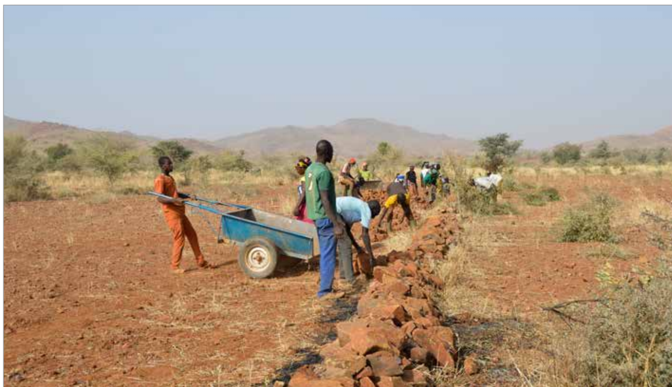
Diguettes à Ronghin en construction
