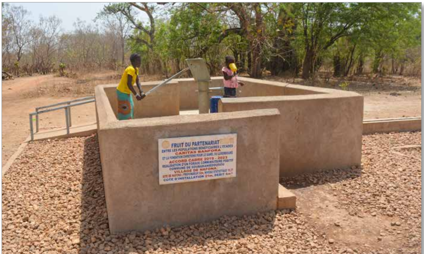
L'accès à l'eau potable est amélioré dans le village de Nafona
