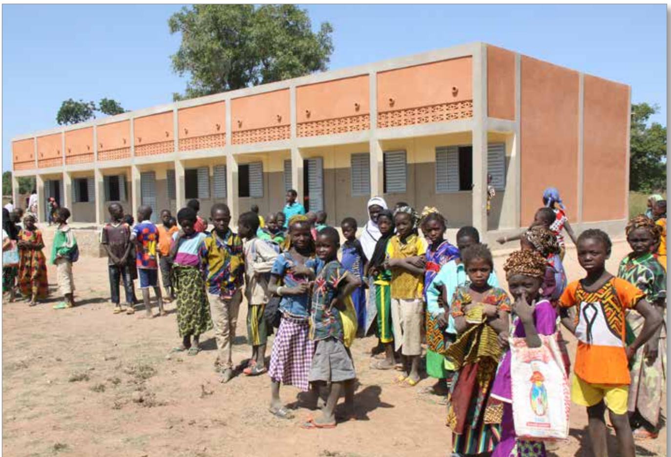
Construction d'infrastructures scolaires
