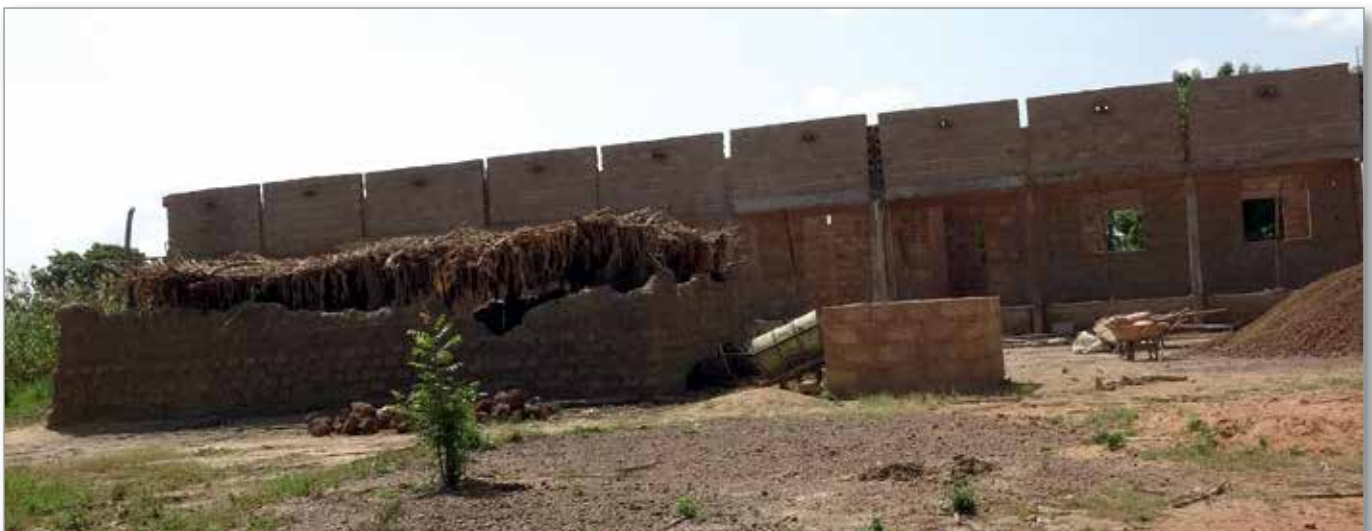
Nouveau bâtiment en construction avec salles sous pailotte en avant plan
